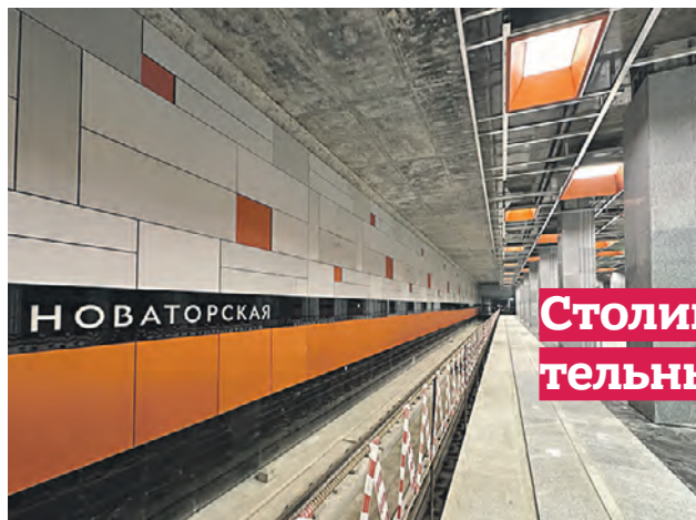
3 октября. Строящаяся станция «Новаторская» Троицкой линии Московского метрополитена
