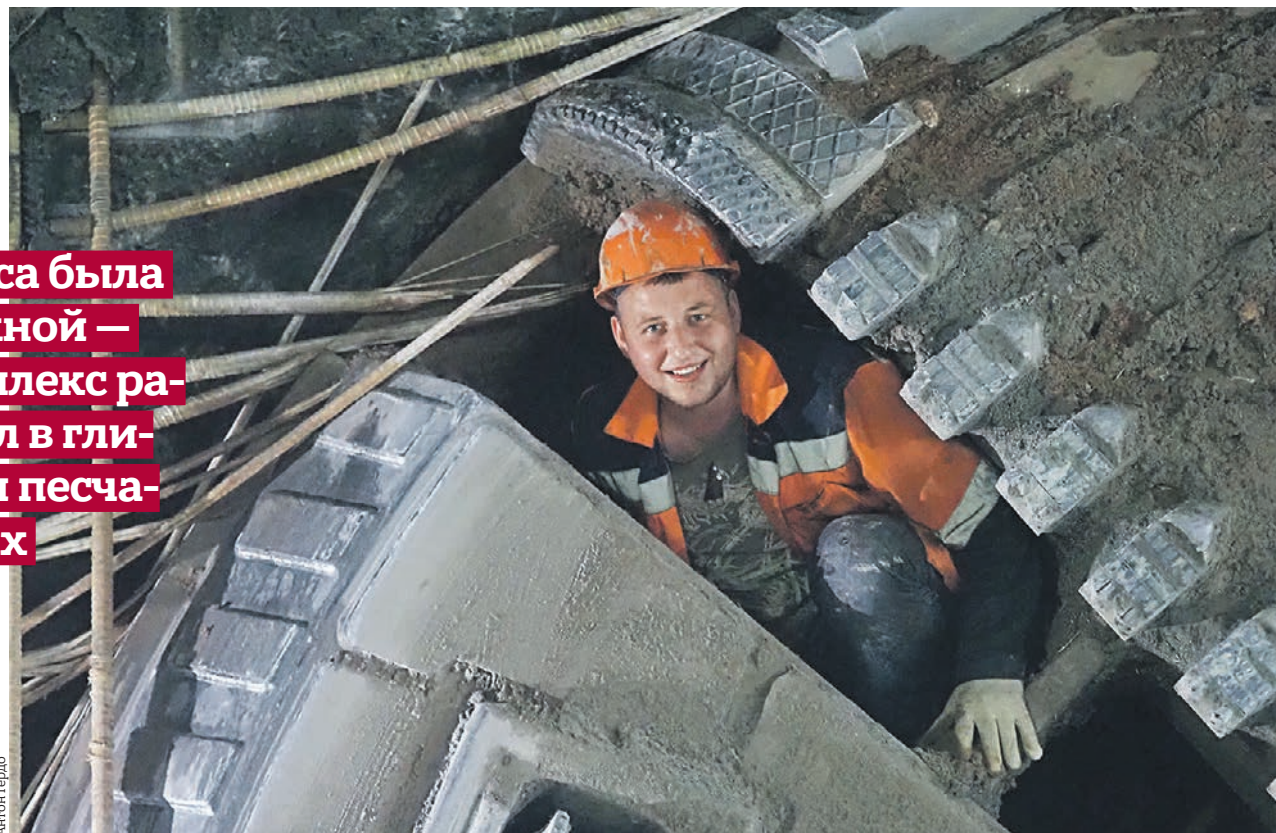
14 сентября 2020 года. Электрогазосварщик Александр Горбунов, обеспечивающий надежность работы тоннелепроходческого щита «Инна»
