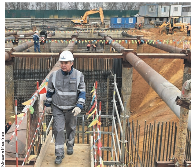
29 октября 2019 года. Стройка участка, который продлит Некрасовскую линию метрополитена
