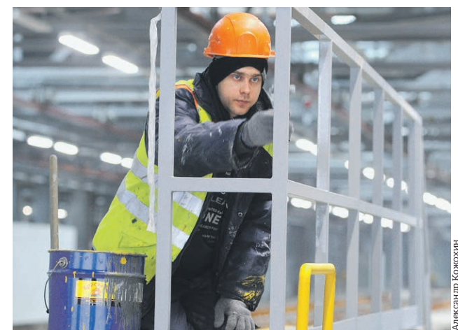
30 января 2018 года. Рабочий Иван Долгов на строящейся станции «Новопеределкино»
