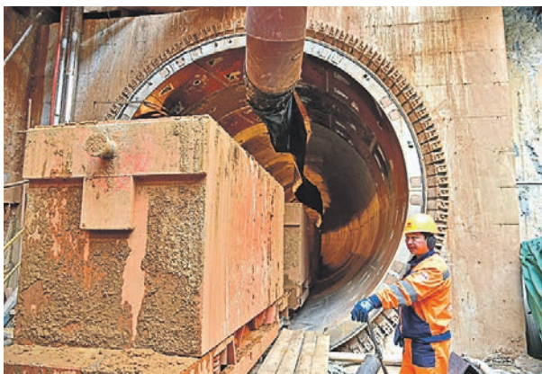
1 декабря 2018 года. Строительство юго-западного участка Большой кольцевой линии
