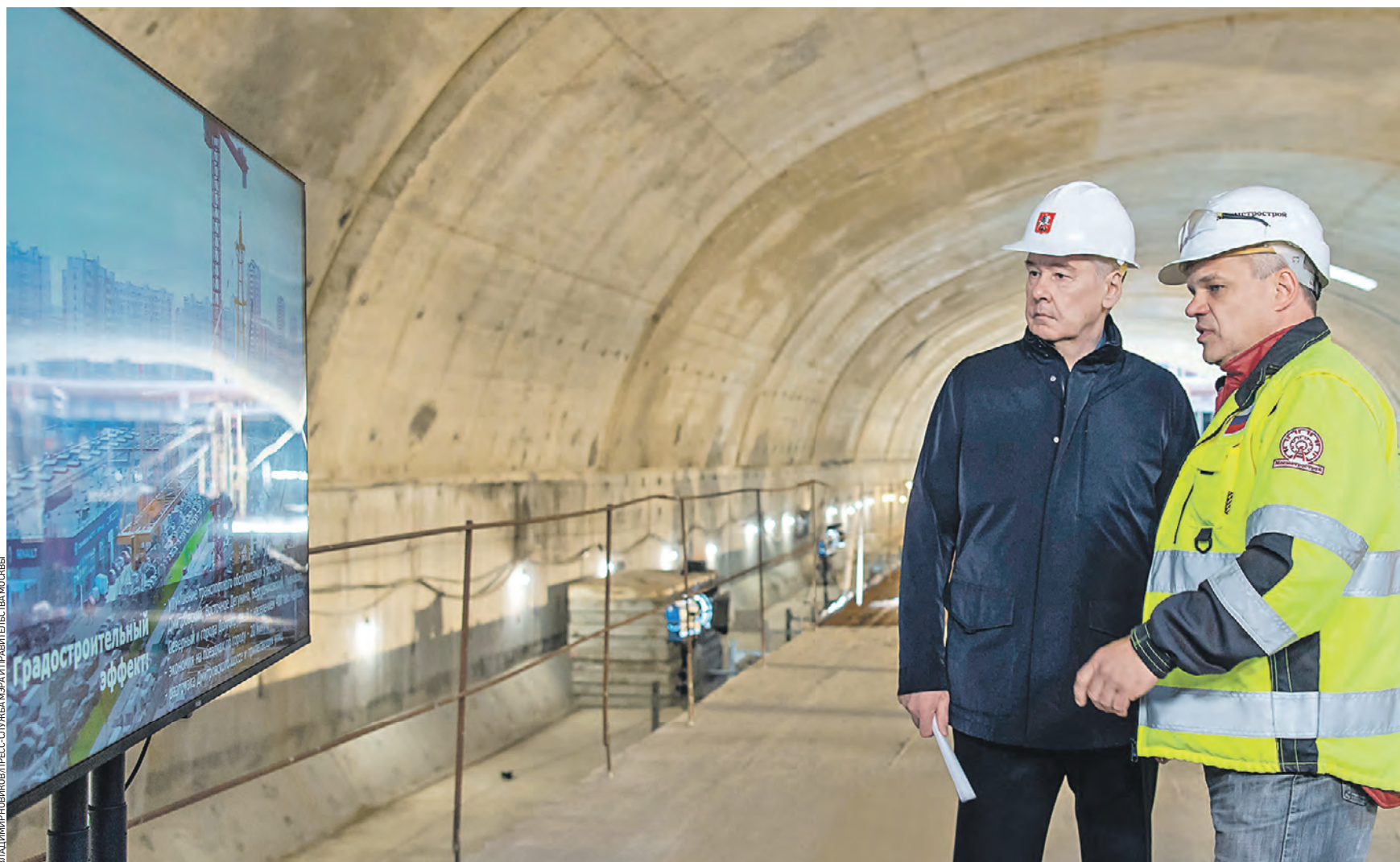
14 апреля 13:59 Мэр Москвы Сергей Собянин и генеральный директор компании-подрядчика «Мосметрострой» Сергей Жуков (справа) осматривают строящуюся станцию «Физтех» Люблинско-Дмитровской линии московского метро — завершить все работы на ней глава города поручил к сентябрю
