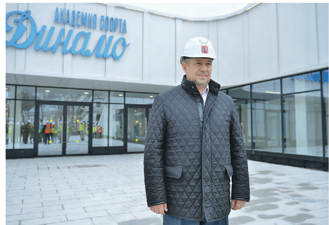
31 марта 11:27 Председатель Мосгосстройнадзора Игорь Войстратенко осматривает ход работ в новой спортивной академии
