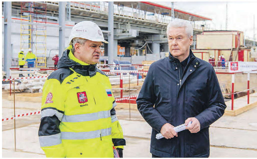
4 мая 17:43 Мэр Москвы Сергей Собянин (справа) и глава «Мосметростроя» Сергей Жуков осматривают ход работ на станции метро «Окружная»
