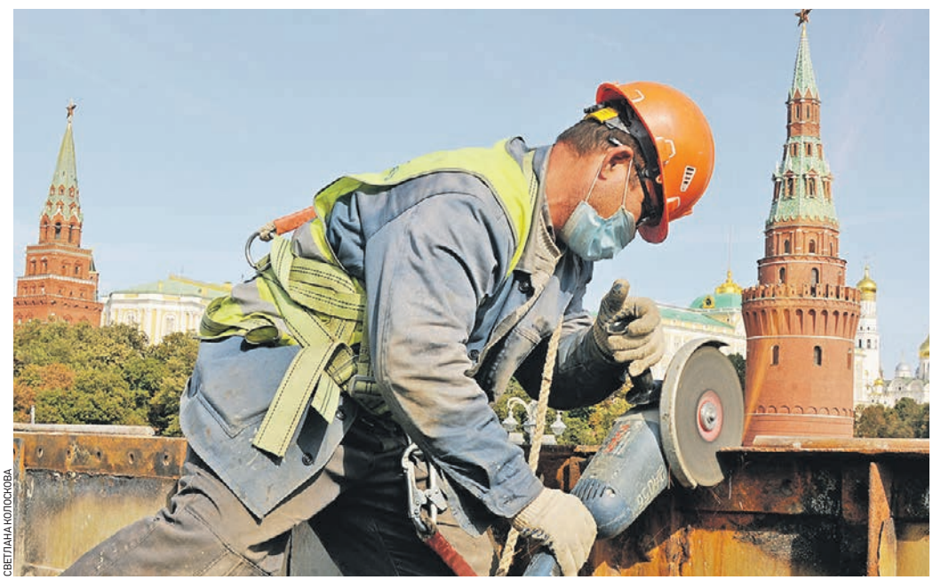
Вчера 12:39 Монтажник стальных и железобетонных конструкций Эдуард Муратов на работах по реконструкции Большого Каменного моста
