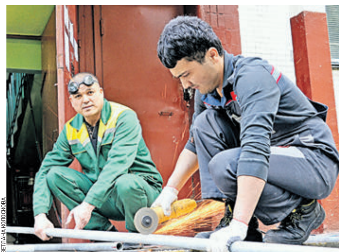
Вчера 11:44 Работники подрядной организации Ильхомжон Рахманов и Ибрагим Мурдуллаев у дома № 16 по улице Ращупкина готовят металлические трубы к установке
