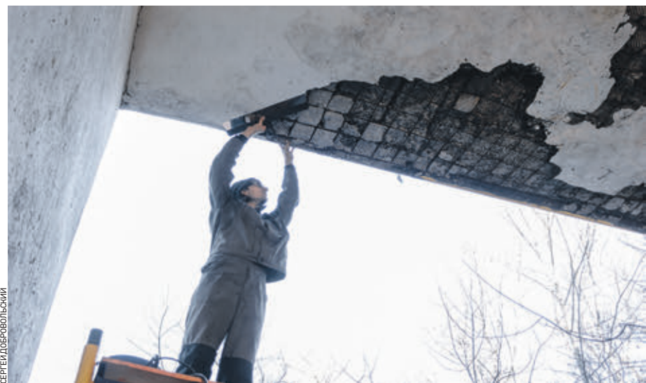
5 апреля 14:25 Асфальтный рабочий Леонид Ерофеев зачищает аварийную штукатурку в арке многоквартирного дома перед началом восстановительных работ
