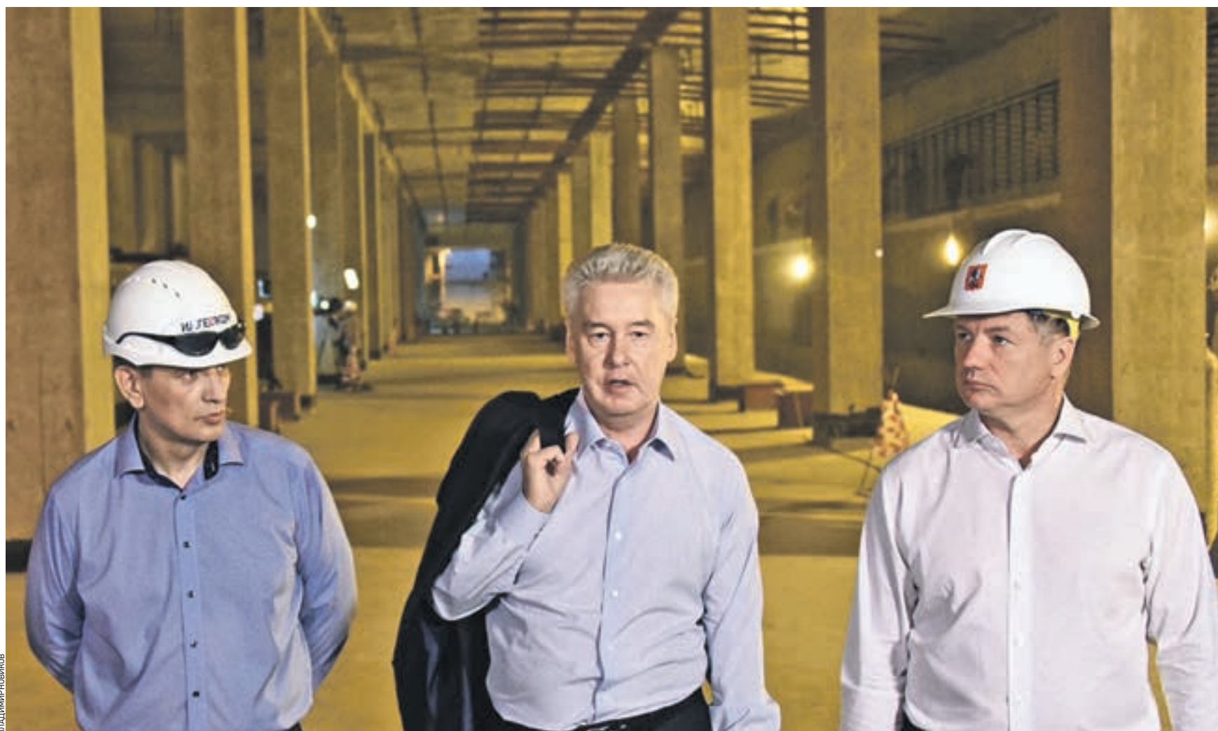
Вчера 11:30 Мэр Москвы Сергей Собянин (в центре), заммэра по вопросам градостроительной политики и строительства Марат Хуснуллин (справа) и исполнительный директор компании-подрядчика Игорь Усольцев проинспектировали ход работ на станции метро «Шелепиха». На платформе ведутся отделочные работы
