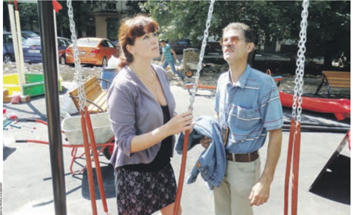
Вчера 12:10 Татарская улица, 6. Муниципальный депутат Алексей Елистратов вместе с замдиректора ГБУ «Жилищник» района Замоскворечье Людмилой Абазиной проверяет качество крепления смонтированных нахлестов
