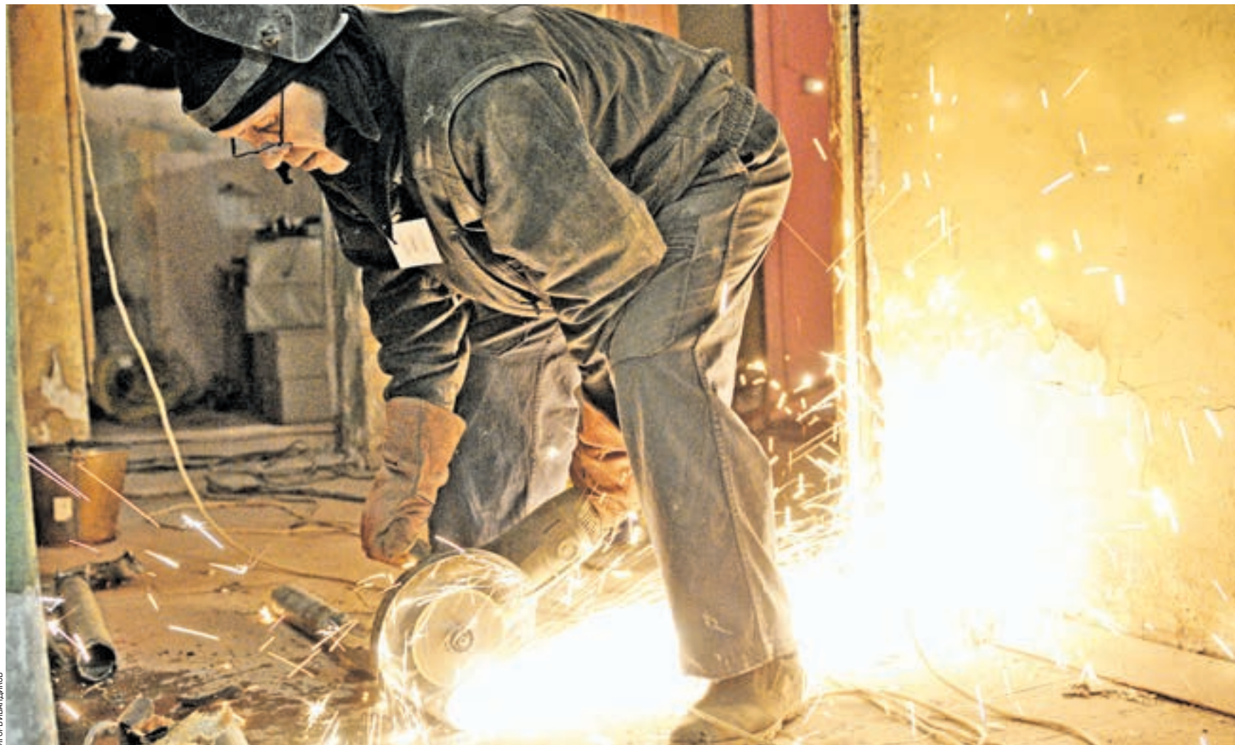
23 декабря 2015 года 12:50 Сварщик Владимир Старушко ремонтирует подвал дома по 1-й Владимирской улице. Перекладка коммуникаций в подвале дома — только часть комплексной программы капитального ремонта. В нее входит также ремонт фасадов, кровли и внутренней отделки здания
