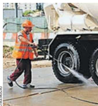
платят 1,73 миллиона рублей штрафов за вынос грязи со стройплощадок на улицы.
