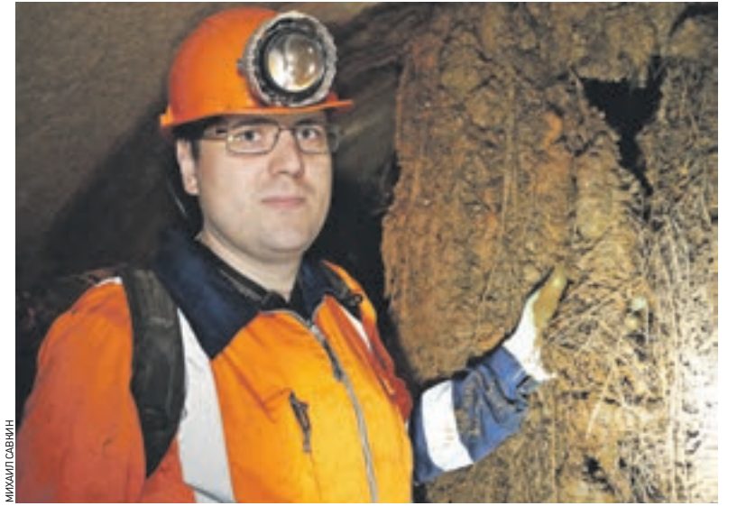
Вчера 00:22 Максим Сметанин показывает корни деревьев, которые с поверхности пробивались сквозь бетон к чистой воде
