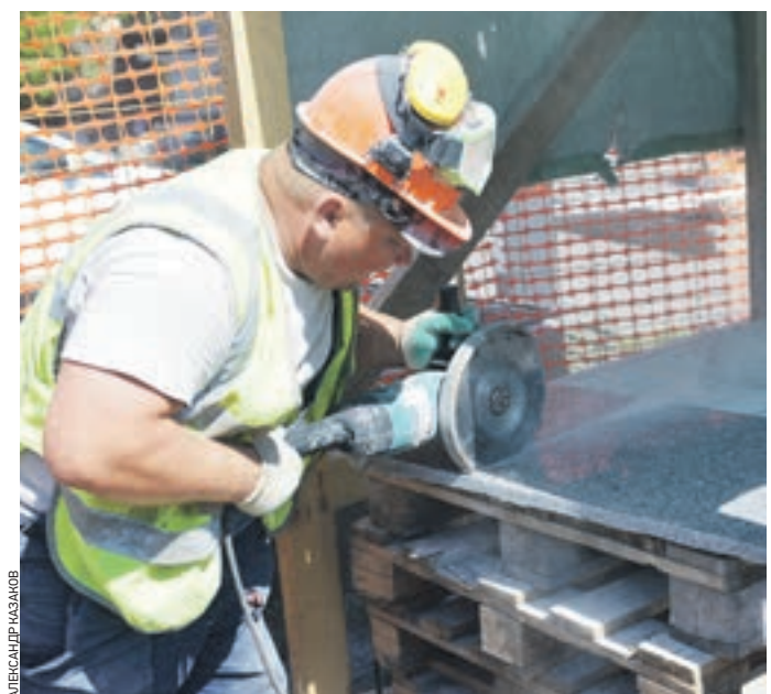
Вчера 10:57 Каменщик Сергей Подотыкин болгаркой нарезает гранитные плиты для облицовки стен перехода
