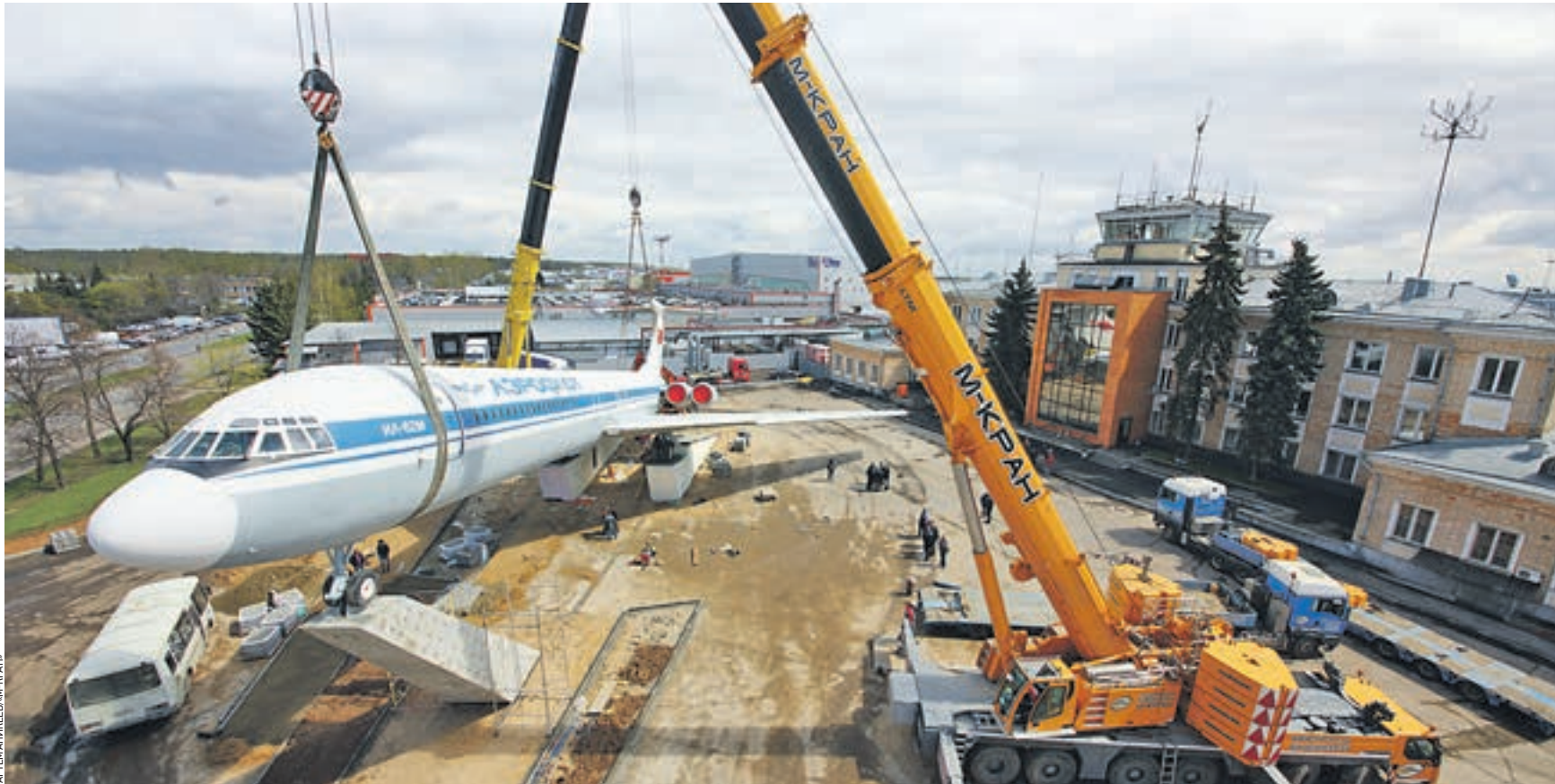
4 мая 2015 года. Аэропорт «Шереметьево». Ответственный момент установки на пьедестал первого советского реактивного межконтинентального пассажирского самолета Ил-62М. Монтажники поднимают крылатую машину двумя автокранами, чтобы ее шасси зафиксировать на постаменте с филигранной точностью
