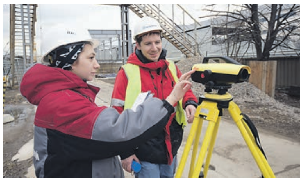
Вчера 14:22 Метростроители Динара Панкратова и Дмитрий Майснер измеряют разность высот поверхности будущей станции подземки «Технопарк»
