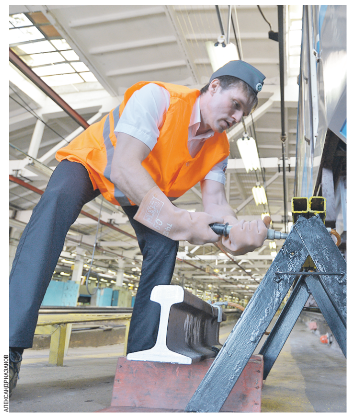
Вчера 10:26 Николай Загорюлькин устанавливает перемычку между контактным и ходовым рельсами — это одно из заданий конкурса
