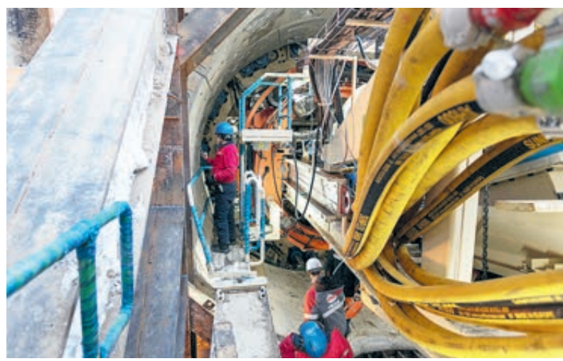
Тоннелепроходческий щит «Мария» работает в Москве.
