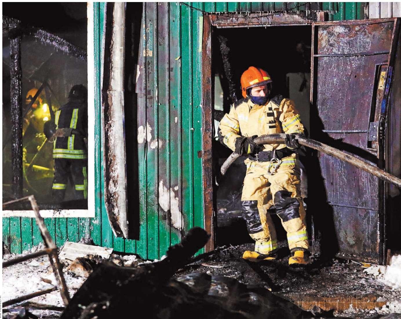
На Таврической, 23 не было ни пожарной сигнализации, ни автоматической системы пожаротушения, ни эвакуационных выходов.
