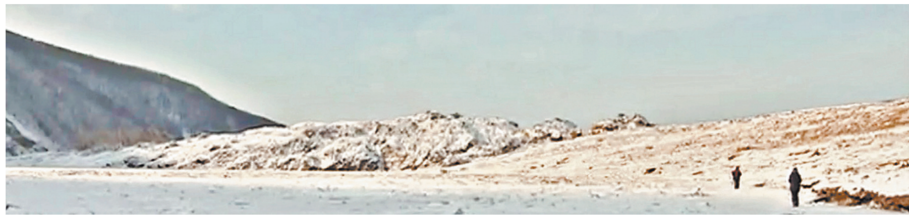
Оползень высотой около 80 и длиной до 700 метров создал перемычку в Бурейском водохранилище. В результате примерно 40 метров русла реки оказались полностью перекрыты.
