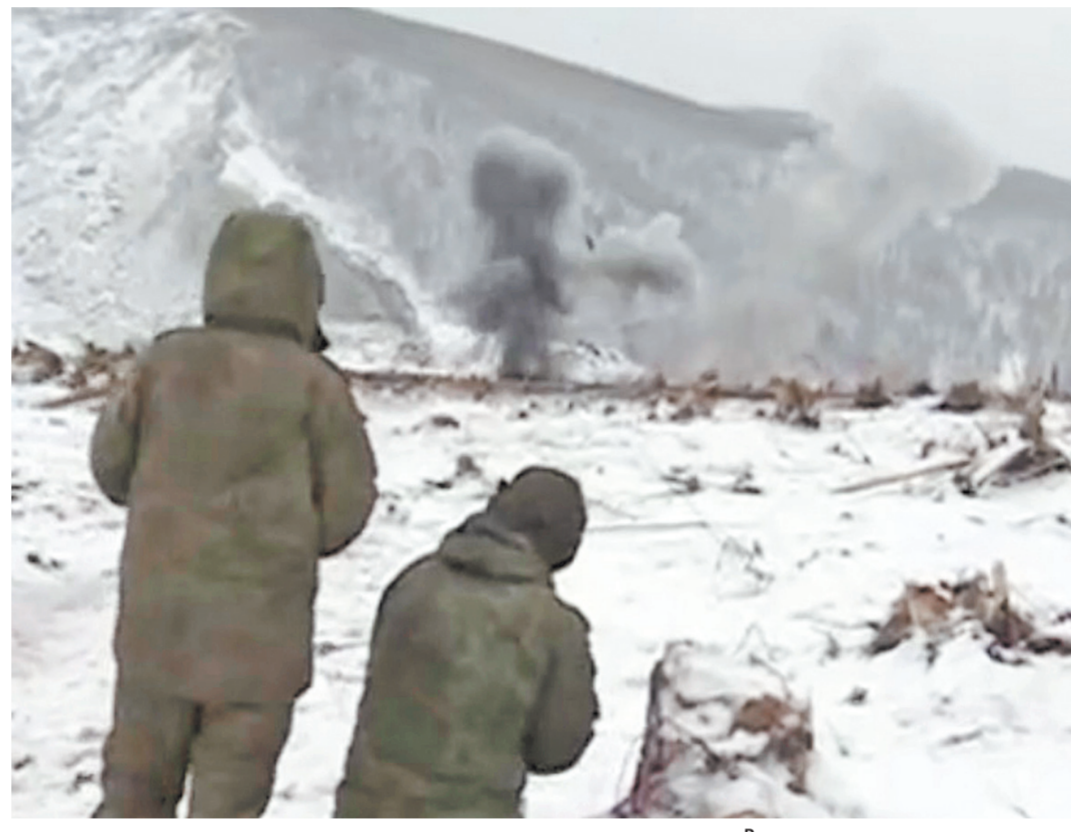
Военные проделывают в оползне взрывным способом прораны — каналы для прохода воды.
