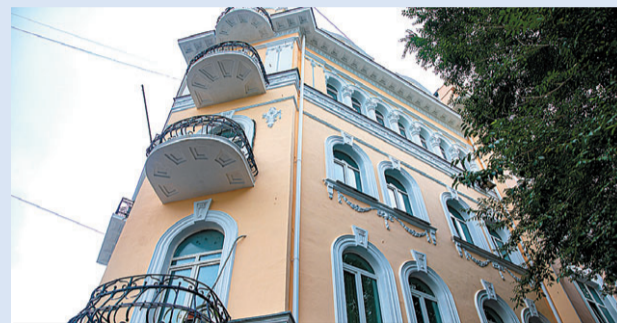
Ремонт фасада здания на Посьетской завершен.
