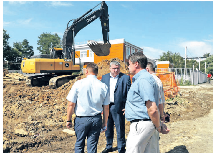
Работы на объекте идут с опережением графика.
