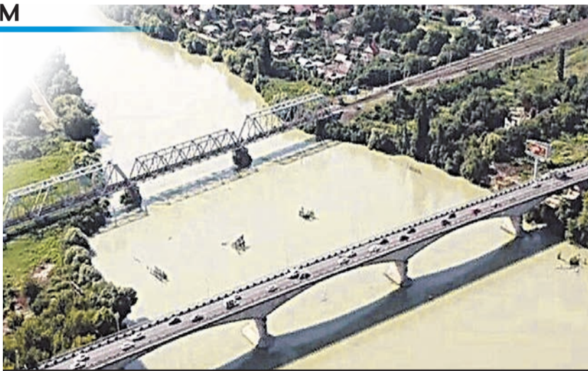
Существующий путепровод уже сильно устарел. И чтобы не рухнул, по нему запретили ездить грузовикам.
