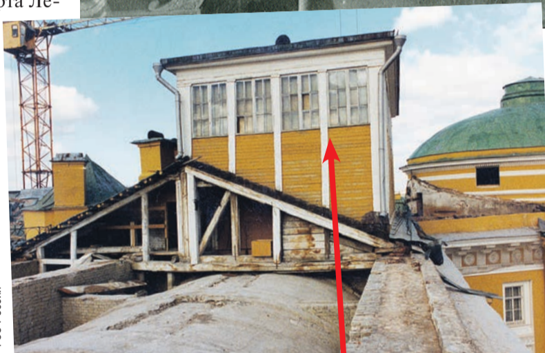
Веранда на крыше здания Сената, специально построенная для больного Ленина в 1922 году. Демонтирована в 1993-м.
