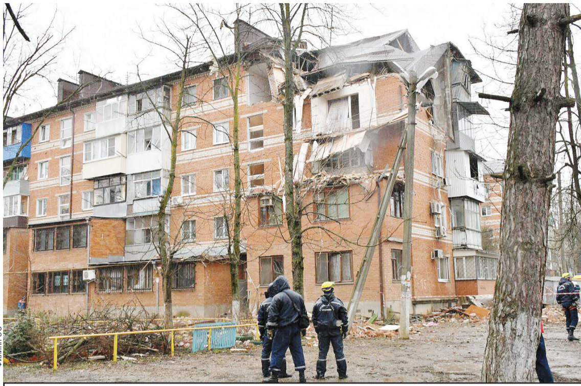
Восстанавливать придется жилье на четвертом и пятом этажах.
