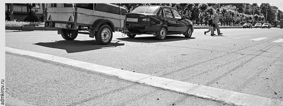
Шумовые полосы создают перед пешеходными переходами.
