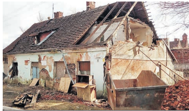
Так здание выглядит сейчас.
