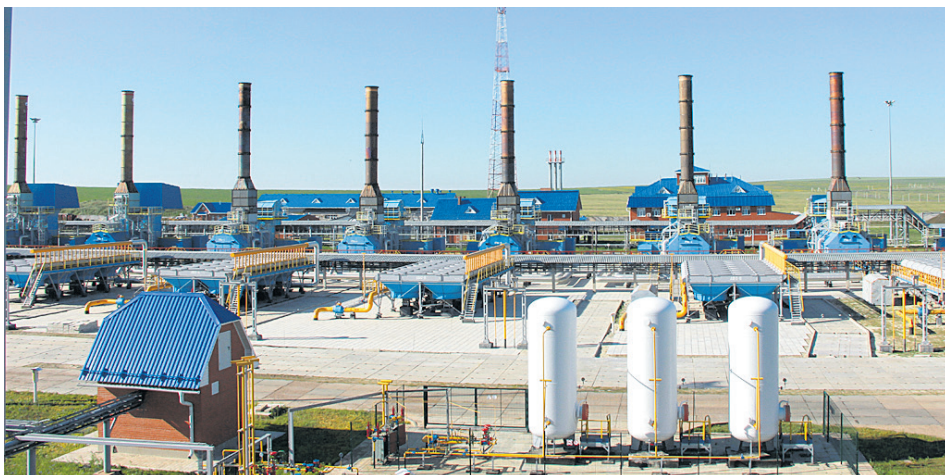
Производственная площадка Совхозного ПХГ в Оренбургской области.
