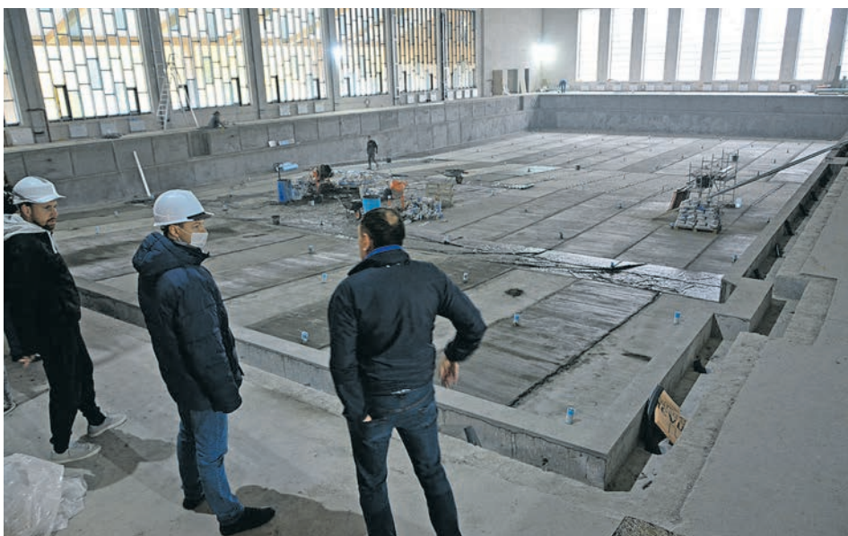
Артур Крупин (второй слева) инспектирует строительство бассейна.
