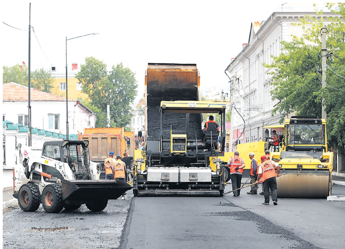
На улице Горького укладывают верхний слой асфальта.
