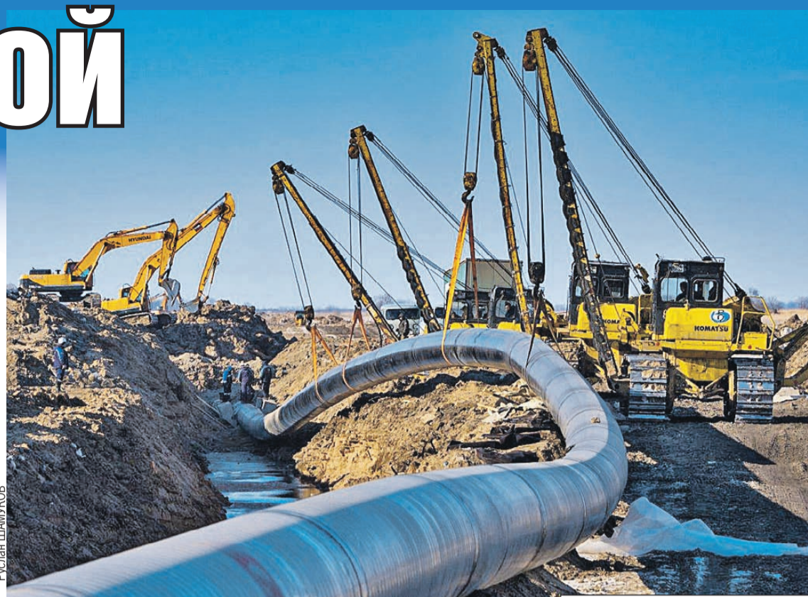
Трубопроводная система Восточная Сибирь - Тихий океан строилась в сложнейших климатических условиях.
