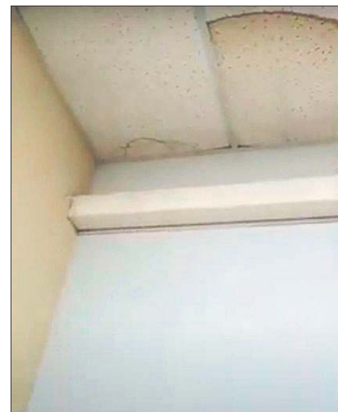
Подтёки на потолке в раздевалке.
