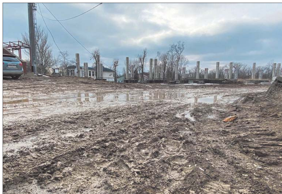
Из-за погодных условий строительные работы на стадионе затягиваются.
