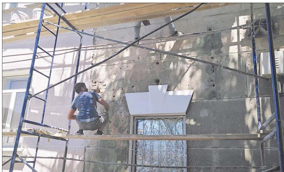
Ремонт дома на ул.Советской.
