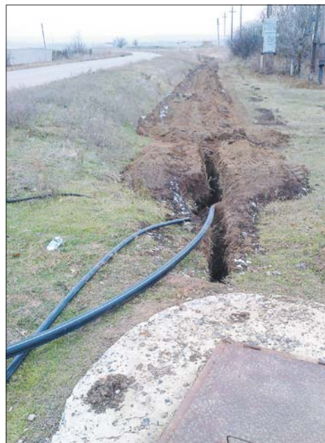
Подключение замененного водовода на х.Новошербаков позволило сократить потери воды.
