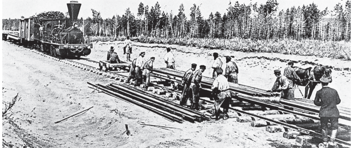
Самая длинная железная дорога в мире протяжённостью 9288 км - Транссибирская магистраль соединяет европейскую часть России, Урал, Сибирь и Дальний Восток. На фото: рабочие укладывают рельсы на участке Среднесибирской дороги от реки Обь до Енисея, 1890-е гг.
